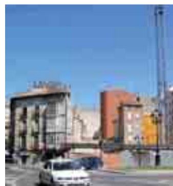
Esquina de la Plaza Vega cuyos edificios serán demolidos.
