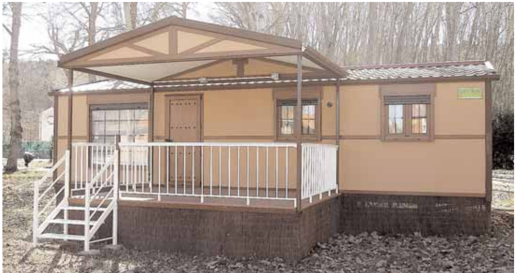
Exterior de una casa móvil de la empresa www.royalnatural.es con su escalera de acceso, puertas, ventanas... y el entorno donde se ubica.
