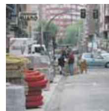
Estado actual de las obras.
