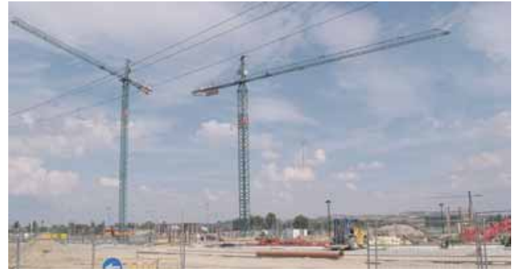
Aspecto actual que presentan las obras de Los Santos-Pilarica
