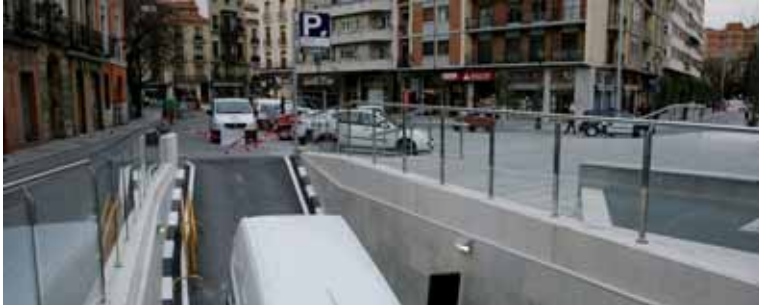
Imagen del actual estado de la rampa de acceso del aparcamiento de la plaza Portuguesale.
