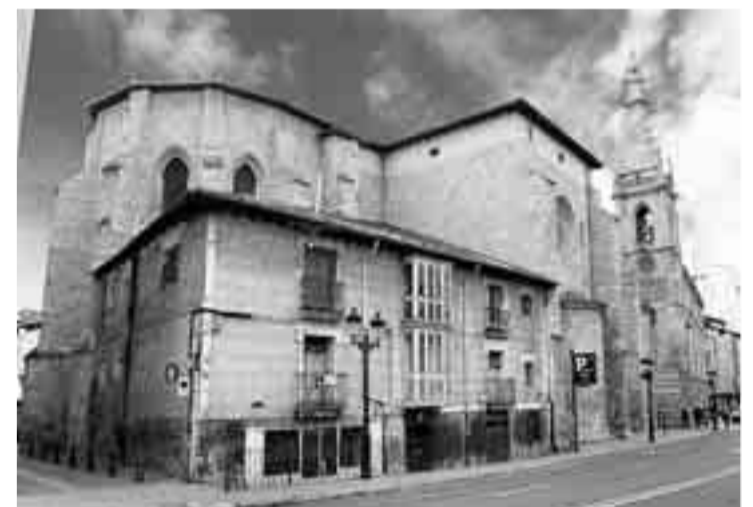
Edificio de la calle La Merced 11, donde está la Casa del Botero.
