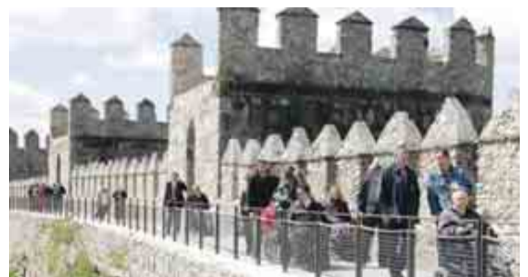
El tramo accesible de la muralla abrió al público en abril de este año.
