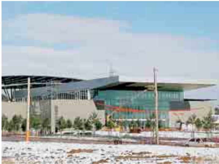
Vista del desvío del ferrocarril, completamente terminado.
