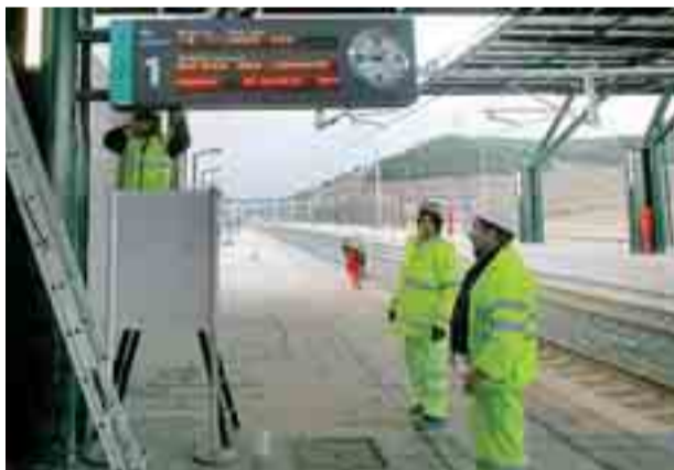
Aspecto de las vías y andenes de la nueva infraestructura.
