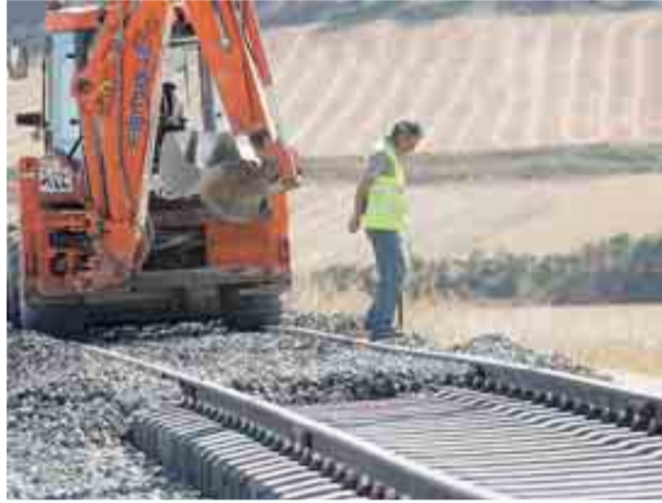
Trabajos de instalación de las vías.
