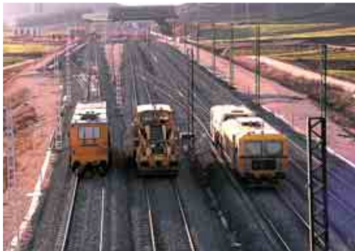
Maquinaria de vía empleada en la construcción de la variante ferroviaria de Burgos. Al fondo, la nueva estación.
