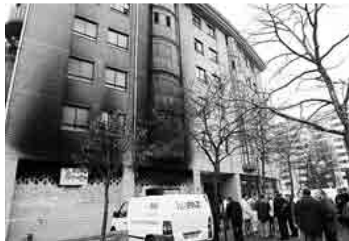
El incendio se produjo al deflagrar una garrafa que contenía gasolina.
