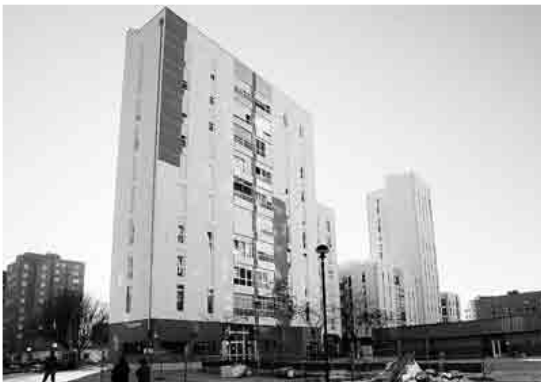
Antes de que concluya 2006 estarán terminadas todas las actuaciones de rehabilitación del área de Río Vena.
