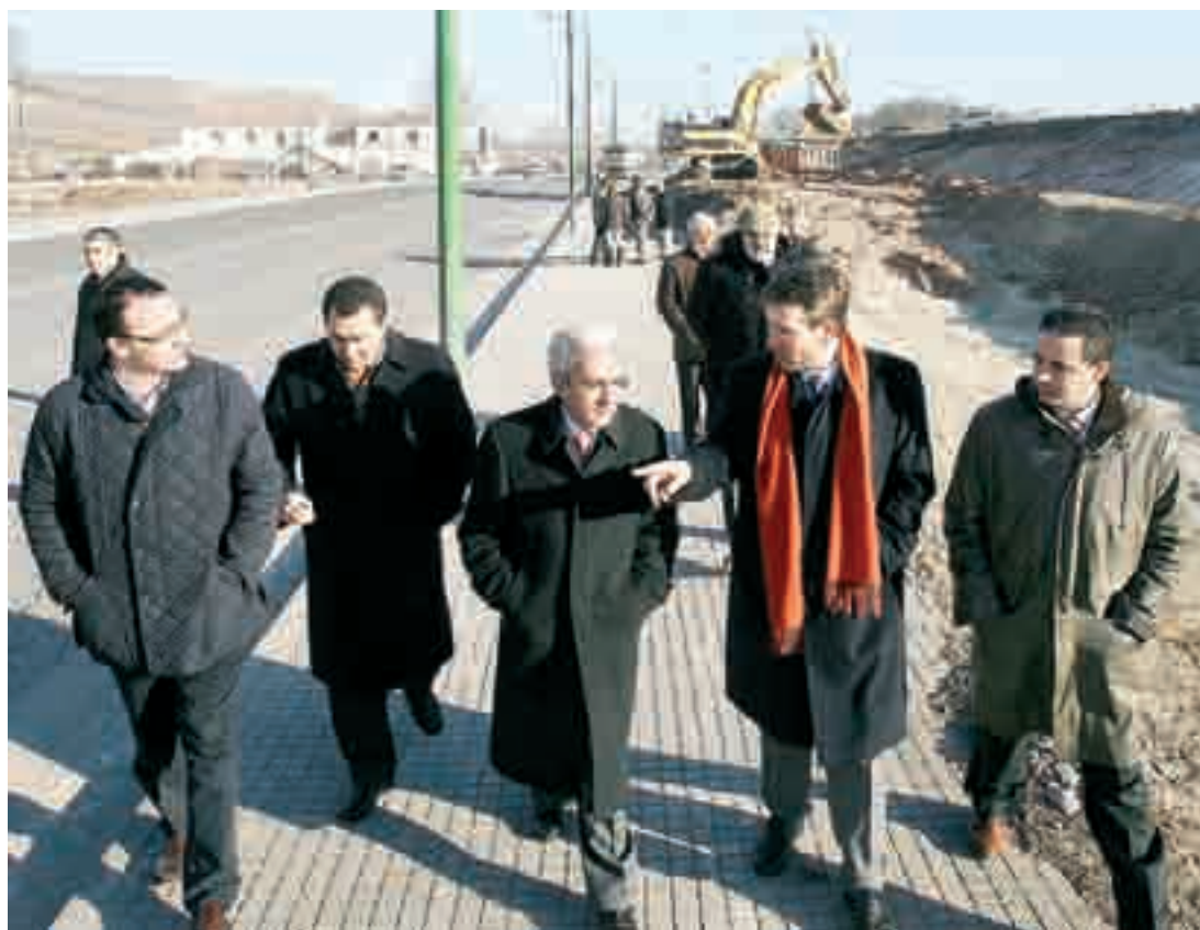
Aparicio y Lacalle visitaron las obras de Fuentecillas junto a responsables de las empresas constructoras.
