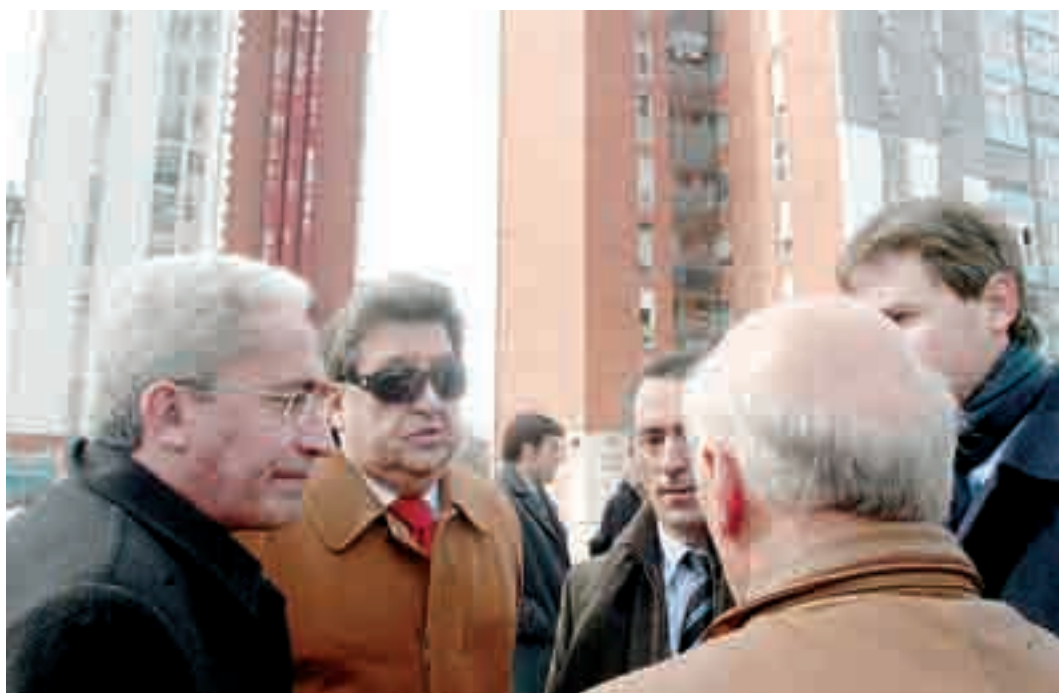
Visita institucional al estado de las obras del ARI del Polígono Río Vena.
