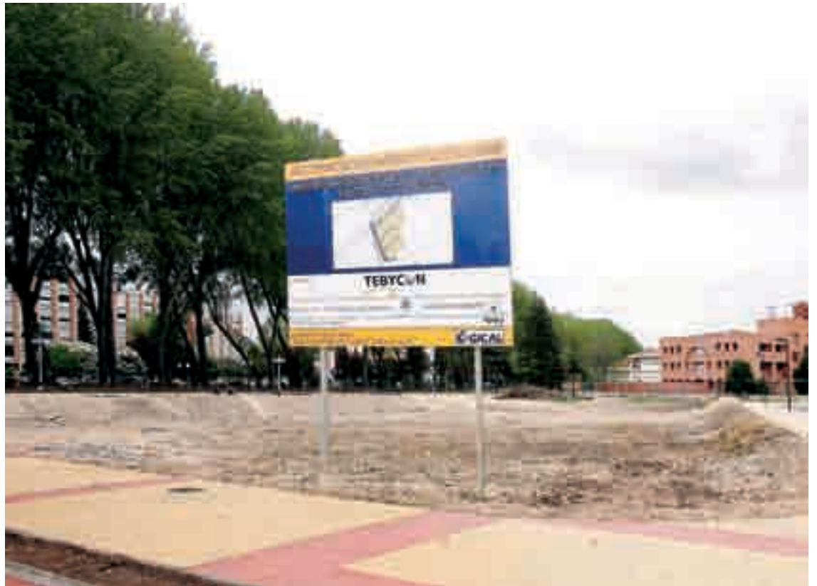
La urbanización de las cuatro parcelas del área de transformación de Flex está casi finalizada.
