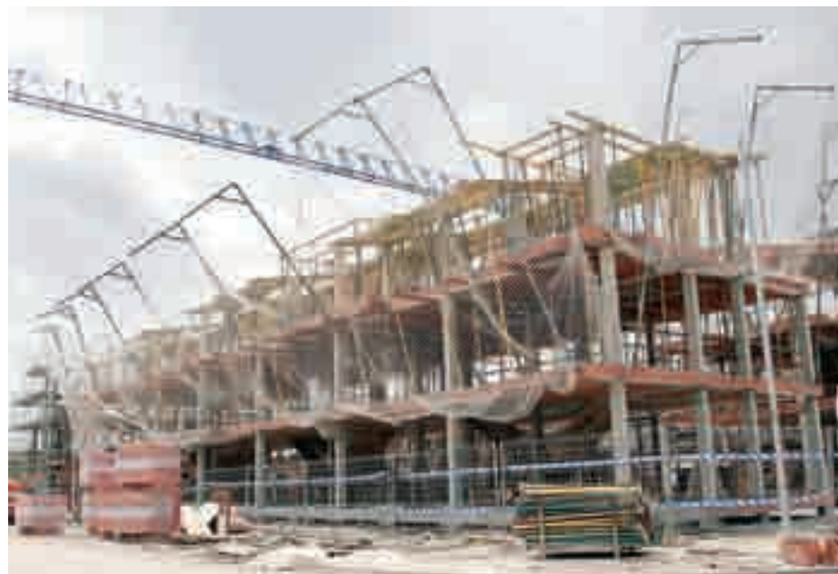
La industria de la construcción registró una producción de 165.160 millones de euros en 2005.
