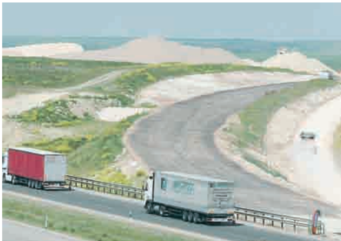
Las obras de la ronda Oeste comenzaron el 18 de diciembre de 2003.
