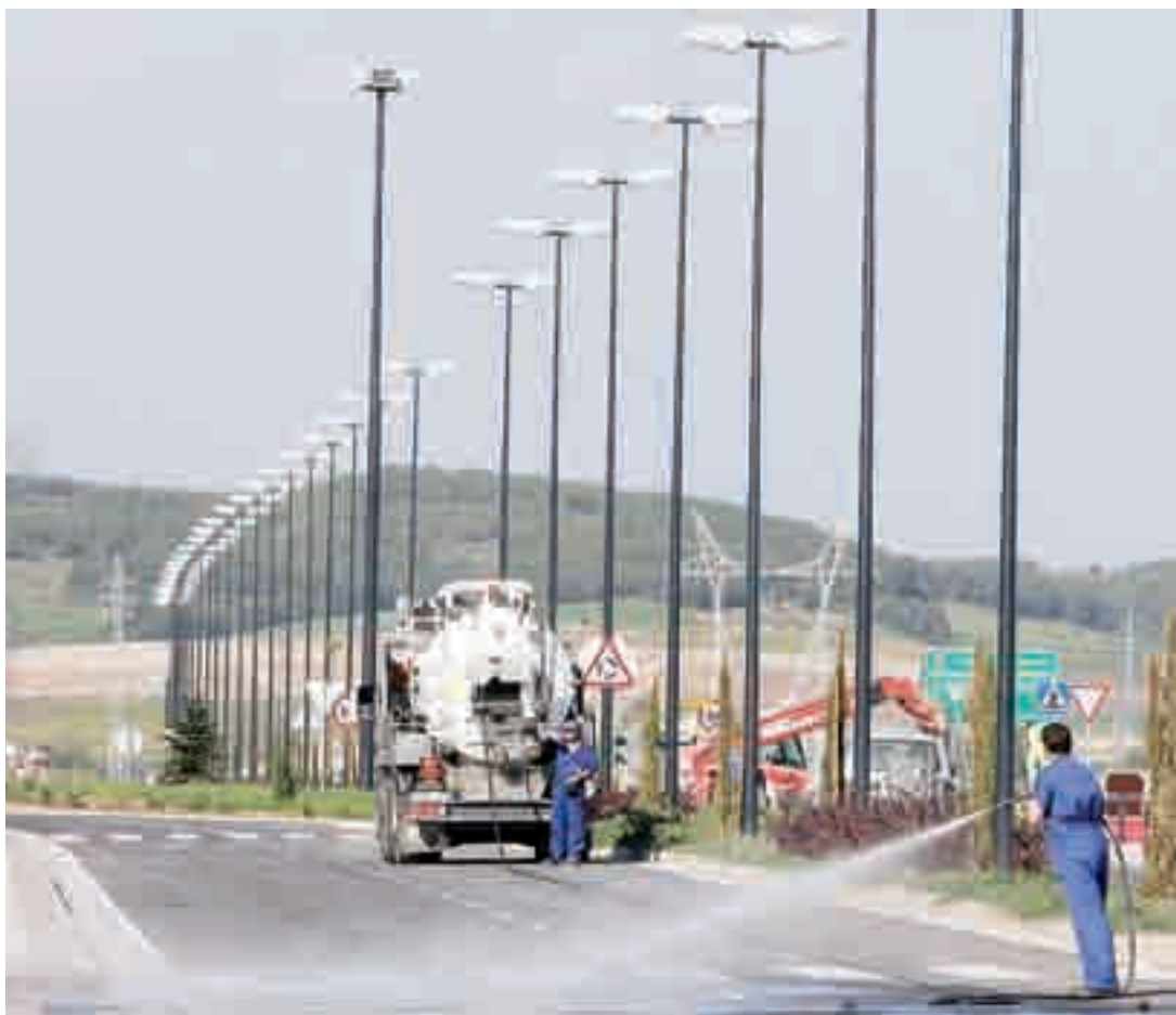
En la tarde del jueves 25 se daban los últimos retoques al nuevo vial de la Ronda Interior Norte.
