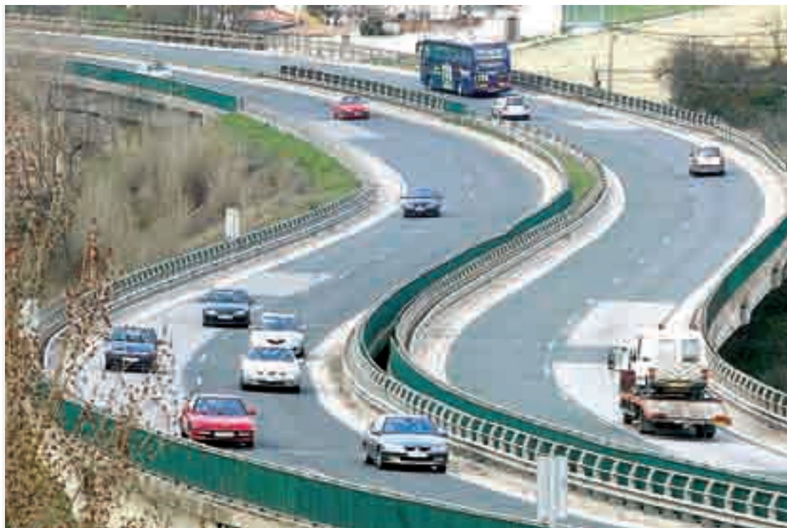
La velocidad inadecuada y las distracciones, principales causas de los accidentes.
