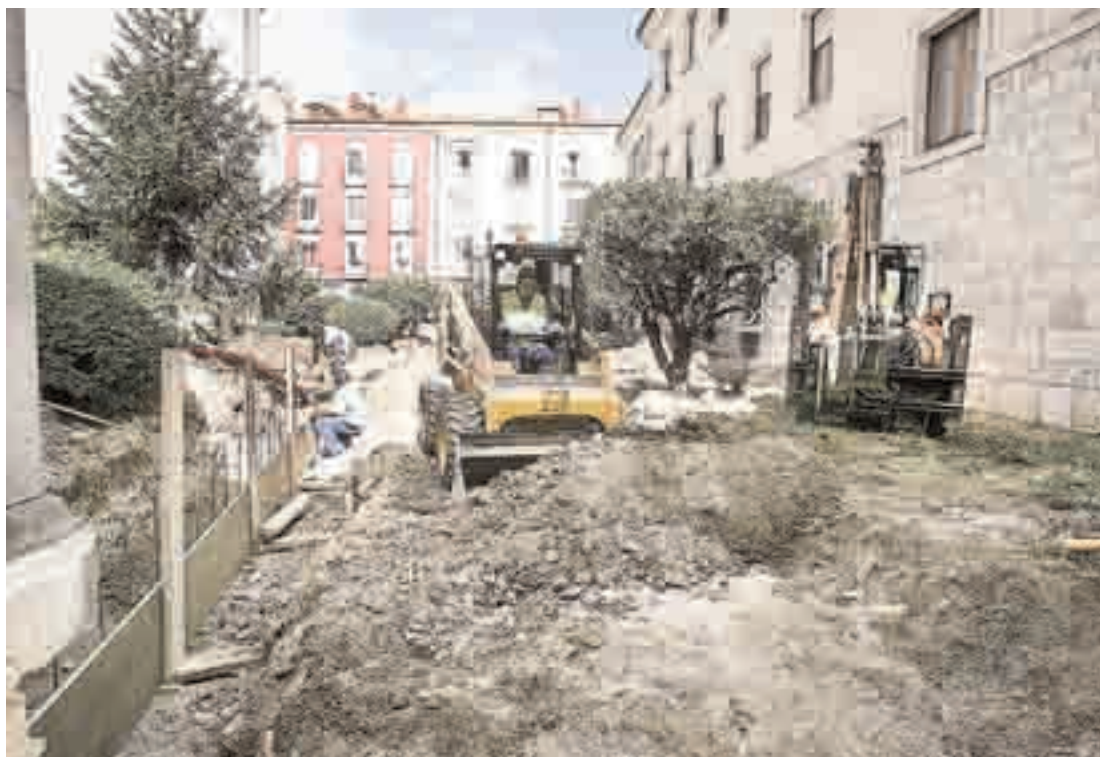
En los jardines de San Lorenzo se están realizando obras de acondicionamiento y equipamiento de mobiliario.
