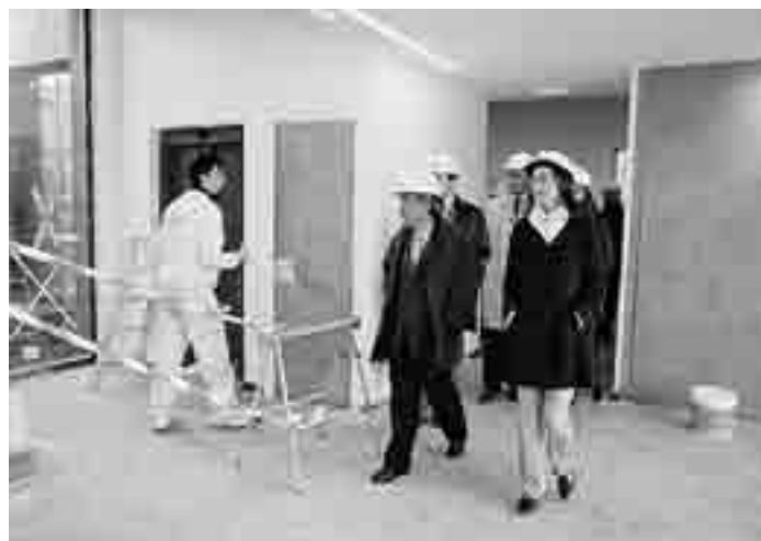
El alcalde visitó las obras del nuevo centro cívico de Huelgas.
