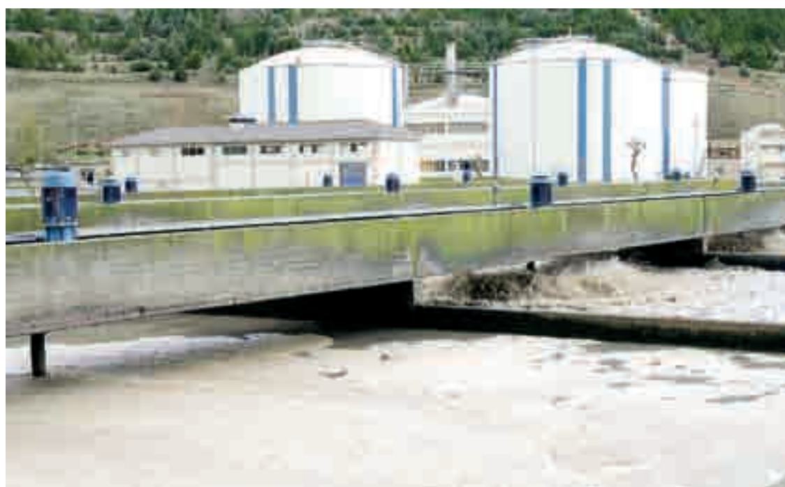
La depuradora de Villalonquéjar se encuentra al límite de su capacidad.
