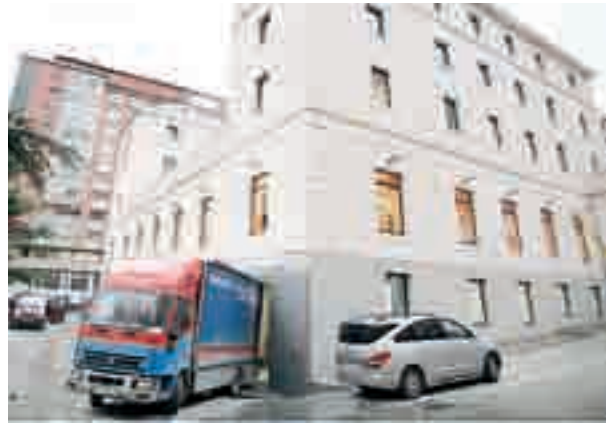
Después de 70 años, la Subdelegación del Gobierno cambia de sede y se traslada al antiguo edificio del Banco de España.
