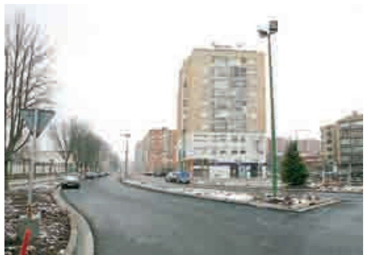
Parte de la nueva avenida de Santa Bárbara ya está abierta.
