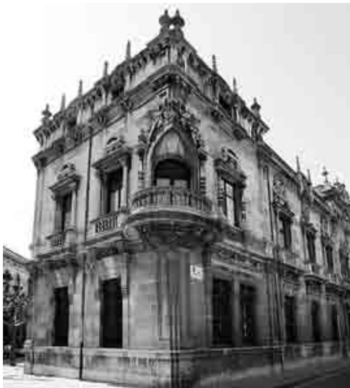
Caja de Burgos aportará 1,2 millones a la rehabilitación del Palacio Arzobispal.
