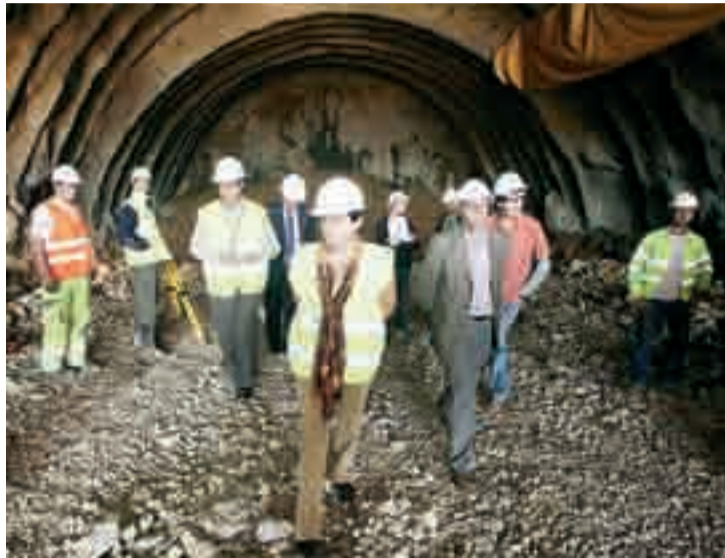
Visita de la subdelegada a las obras de la ronda Norte.
