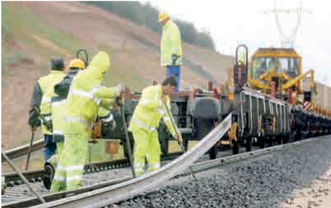
El tren 'carrilero' se encarga de la colocación del tendido ferroviario en las obras del desvío.
