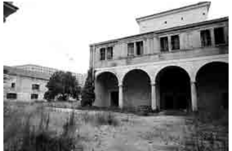
Las obras de rehabilitación podrán comenzar el próximo mes de agosto.
