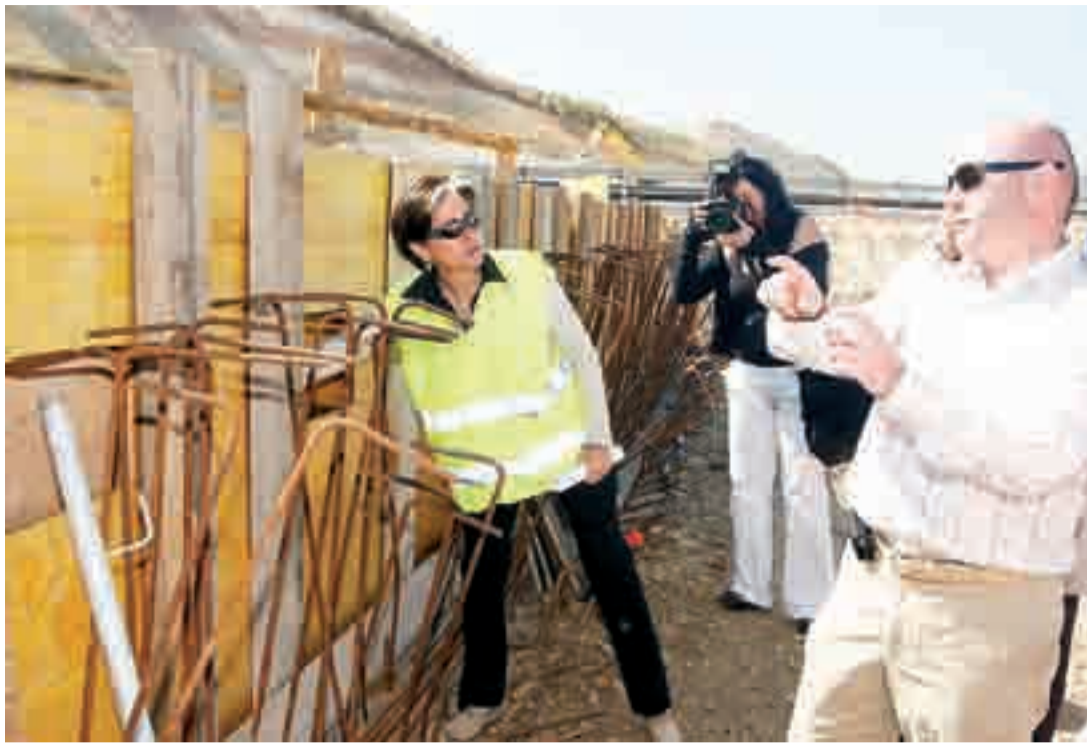
Visita de la subdelegada del Gobierno, Berta Tricio, a las obras del nudo Landa.
