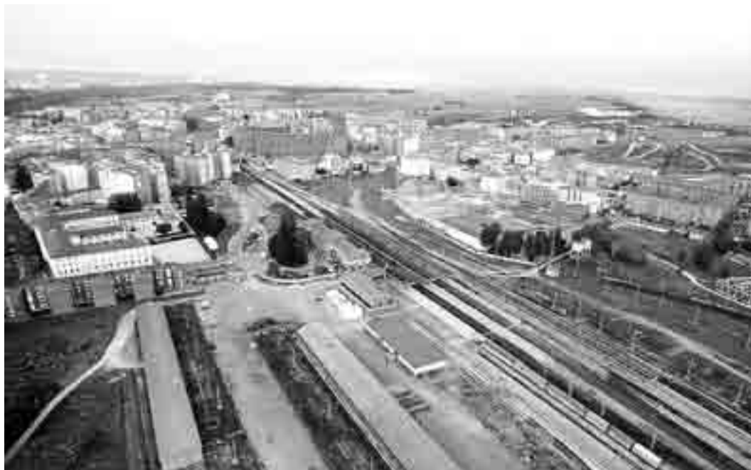
El desvío ferroviario supondrá que las vías dejen de ser un referente de la actual fisonomía de la ciudad.
