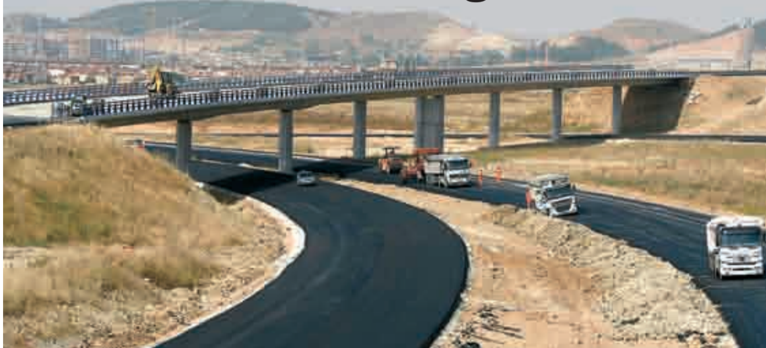
La variante de la N-623 y el tramo Villafría-Rubena de la N-I tendrán dos calzadas.
