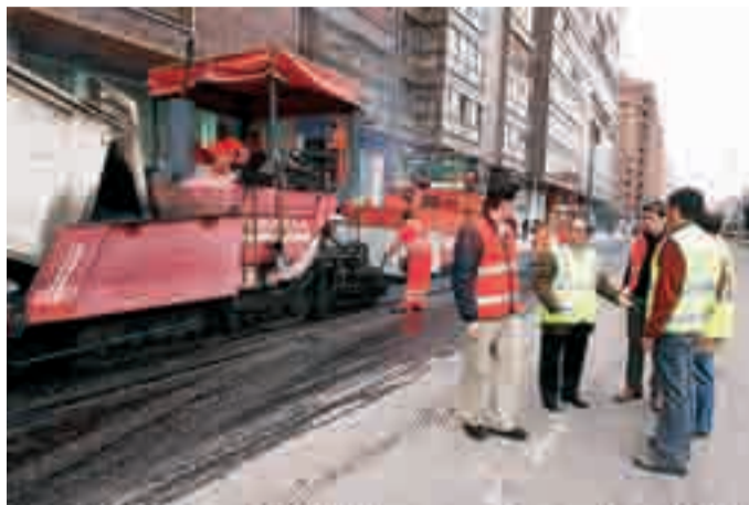
González Braceras visita las obras de la avenida de la Paz.
