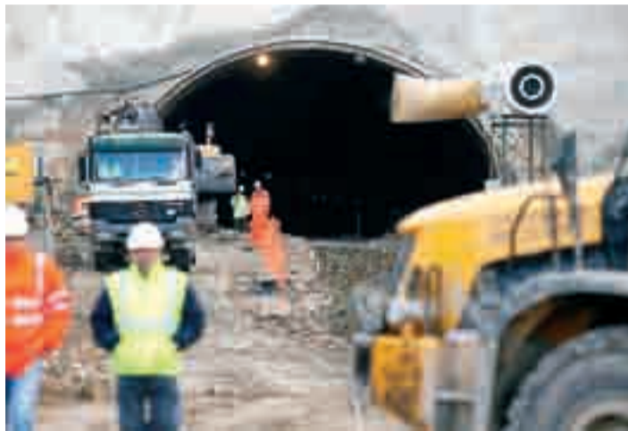
Estado de las obras en el túnel del tramo Villafría-Villatoro.
