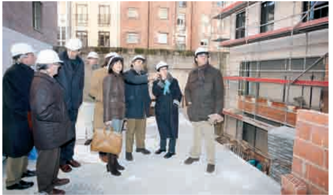
Visita de Berta Tricio y Marisol González a las obras de construcción del nuevo albergue de peregrinos.
