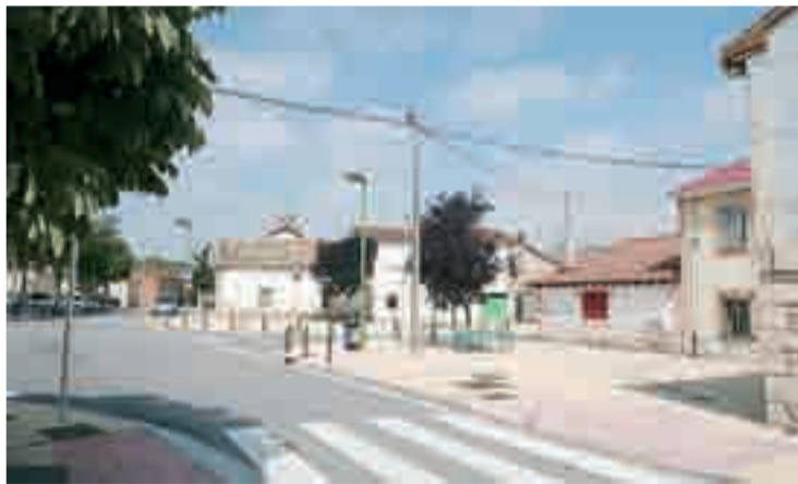
Las obras de urbanización en Castañares se iniciarán en pocos meses.
