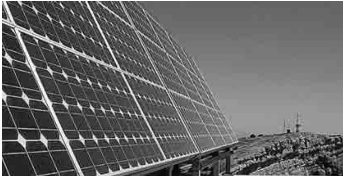
Imagen de uno de los paneles solares instalados en Castilla y León.
