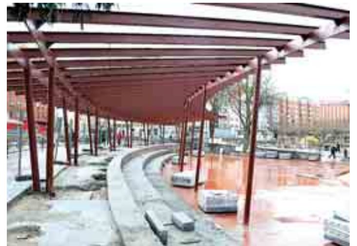
La plaza de San Agustín contará con una pérgola junto a la calle Madrid.
