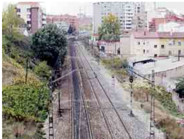
Bulevar ferroviario en el tramo de las Casillas.
