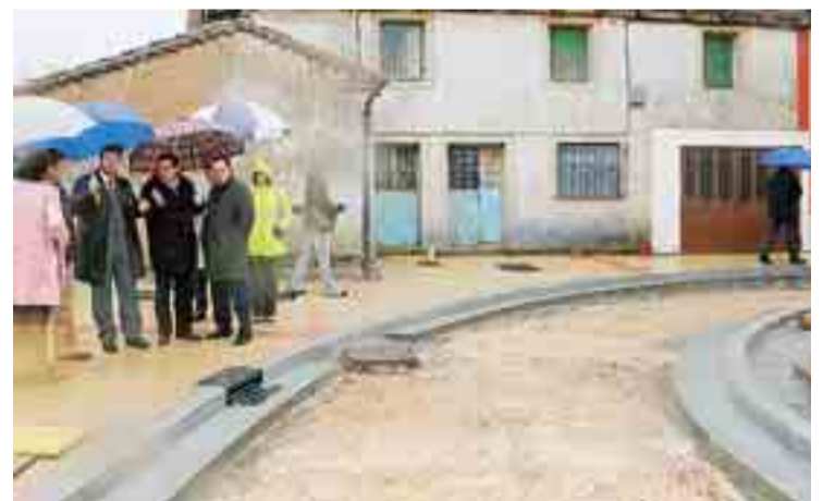
Los responsables municipales en la visita a las obras el martes 14.
