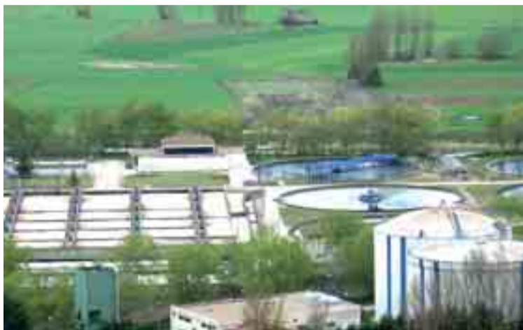
La depuradora se encuentra a la espera de una necesaria ampliación.
