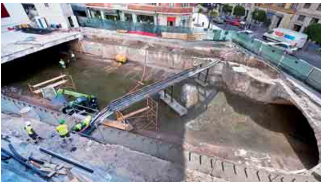
Imagen de los trabajos que se llevan a cabo en la plataforma sobre el río en la calle Gran Teatro.
