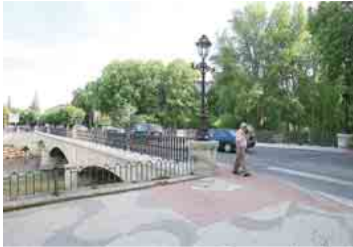
El puente contará con un carril más y mayor anchura en las aceras.
