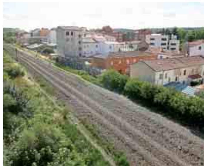
Imagen actual del trazado del bulevar a su paso por las Casillas.
