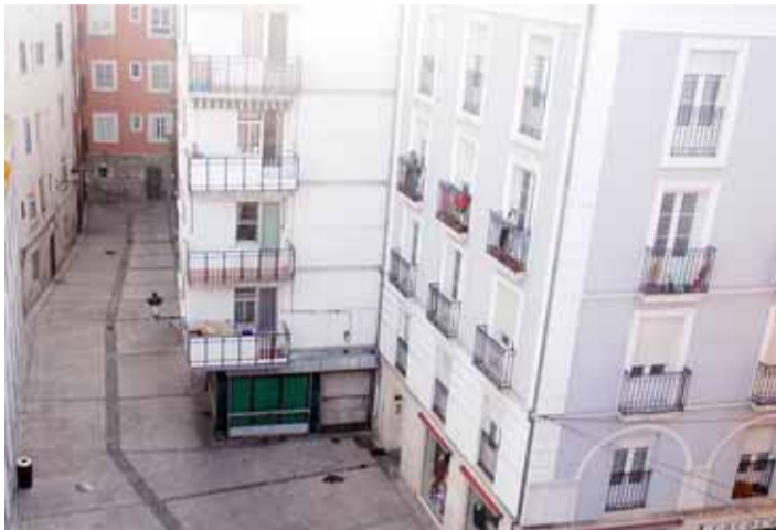
Los trabajos en Sombrerería comenzarán en la zona de Gaona Jardín.
