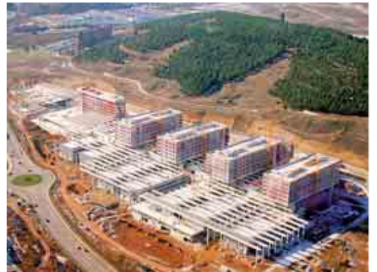
Aspecto actual de la ejecución de las obras del hospital.
