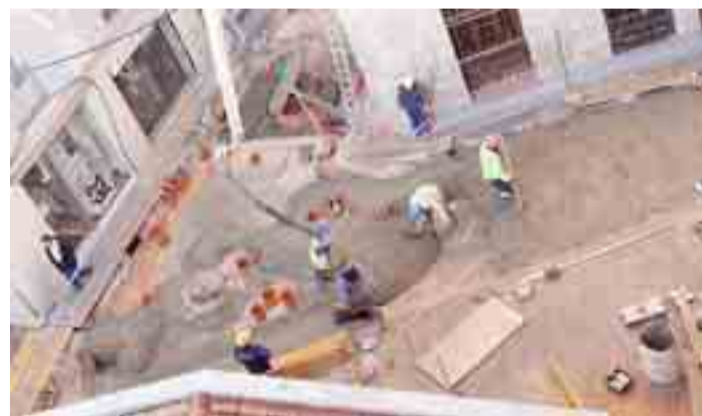
La nueva urbanización de Sombrerería, a punto de concluir.
