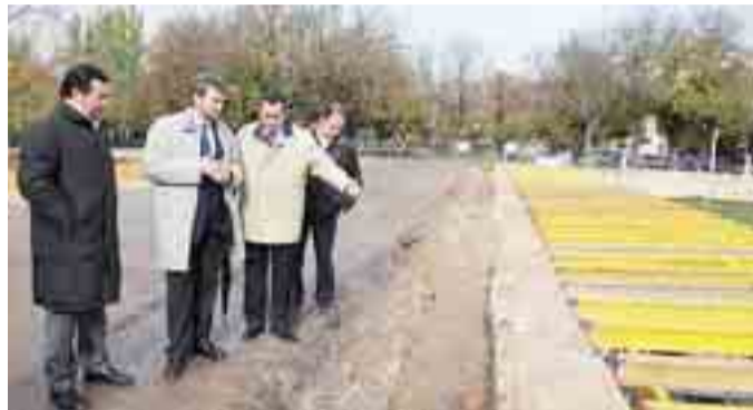
Visita a las obras de ampliación del nuevo puente Castilla.
