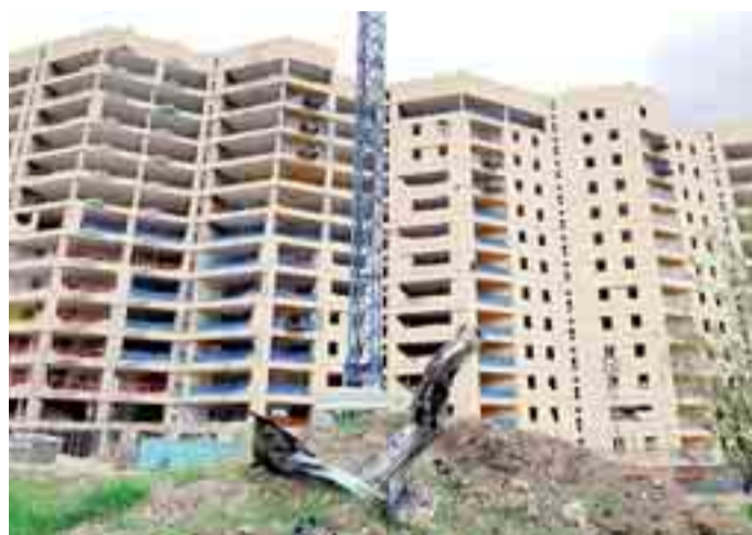
A pesar del atentado, la estructura del edificio "es válida".
