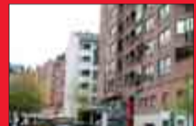
VADILLOS Piso para entrar a vivir. Totalmente exterior. CUATRO dormitorios, salón, cocina, baño, aseo, Garaje y trastero.
