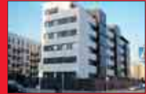
JARDINES DE LA ESTACIÓN Pisos, apartamentos y áticos con terraza de 1-2-3 y 4 dormitorios. A estrenar. Garaje y trastero. Exteriores. Urbanización privada, piscina-padel.
