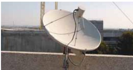
Antena parabólica con la que solucionar los problemas de cobertura TDT.
