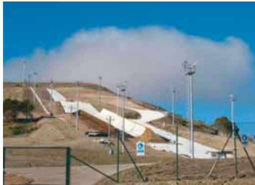
Vista del estado actual de las instalaciones en Villavieja del Cerro.
