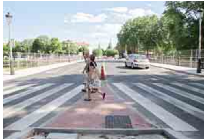
El puente Castilla tiene ya operativos los cuatro carriles.
