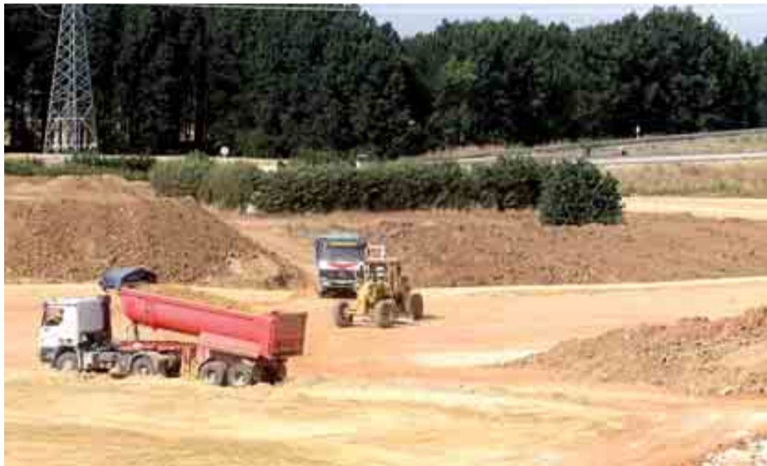
La rescisión del contrato de la obra correspondiente al tramo Villalbilla-Quintanadueñas, si el Ministerio de Fomento no rectifica, supondrá años de retraso para completar la circunvalación de Burgos.
