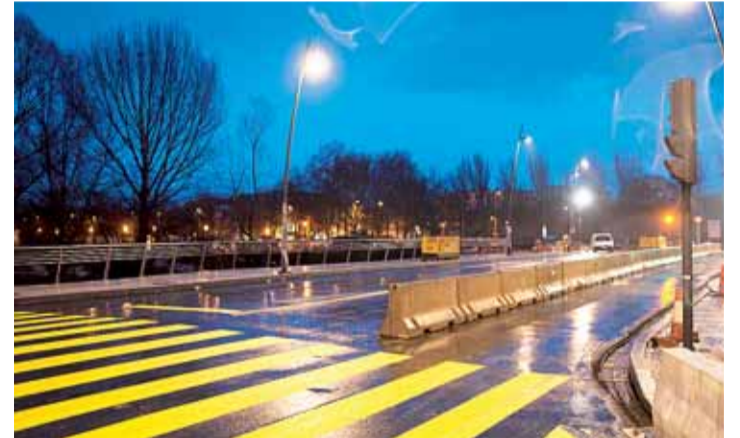
La calzada del nuevo puente de la Evolución tiene cuatro carriles.
