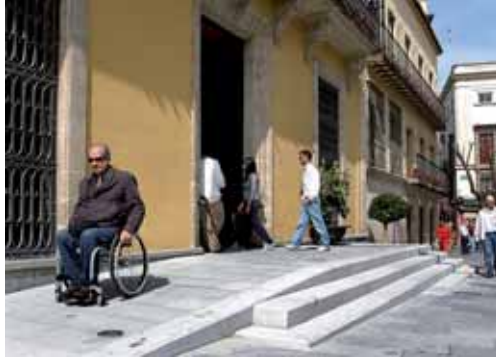
Eliminación de barreras arquitectónicas y adecuación de entrada.
