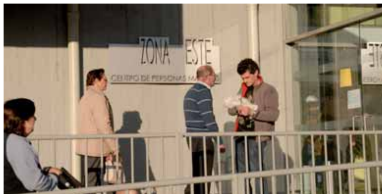
Fachada principal del nuevo Centro de Día para mayores de la Zona Este.
