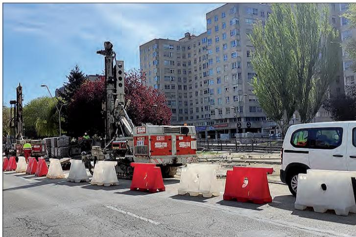
Obras de reparación del hundimiento de aceras y calzadas de la Avda. Reyes Católicos.
