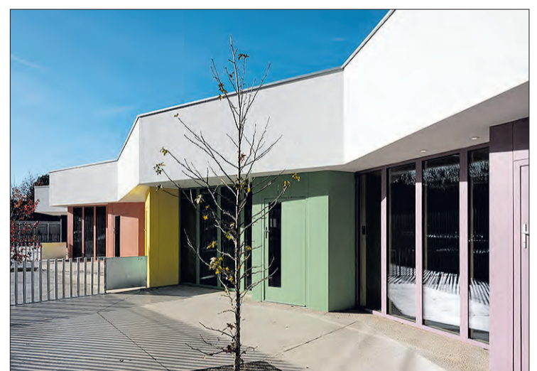
El edificio fue promovido por el Ayuntamiento de Burgos.
